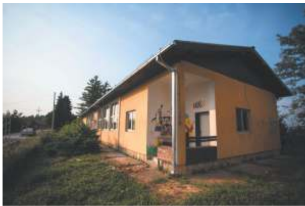
објекат пре реконструкције
