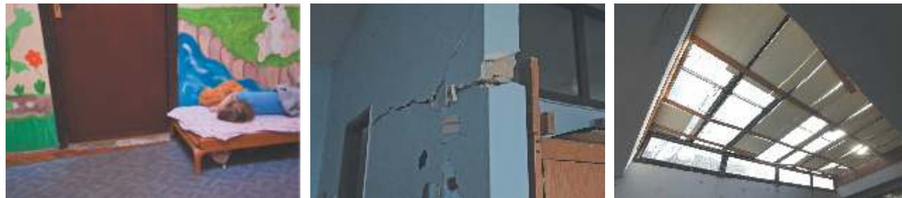
објекат пре реконструкције
