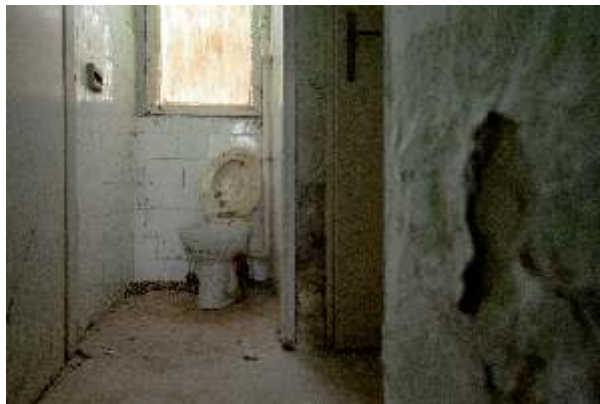
објекат пре реконструкције
