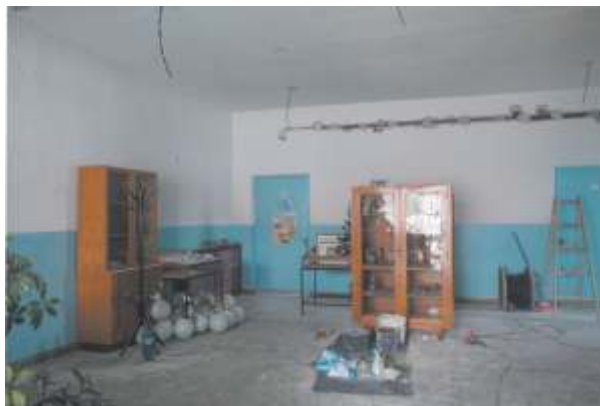
објекат пре реконструкције
